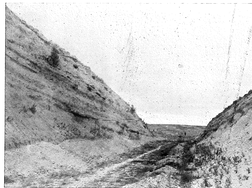
Trincheras del ferrocarril Madrid-Burgos, en construcción, al norte del cruce de ésta con la carretera de La Granja de Guimara a Cilleruelo de Arriba.
